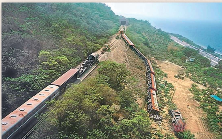
上圖照片為當時新聞媒體蘋果日報之記者所拍攝，該列車要開往高雄，但甫出隧道掩體即出軌翻覆在斜坡，未翻覆傾斜的列車後半段即第1至第5車廂已先被拖離現場。
